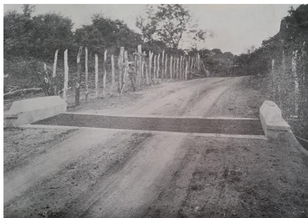
Figura 25: Mata-burros construído na estrada Ingá-Campina Grande em 1936. Fonte: DEPPB (1938)
