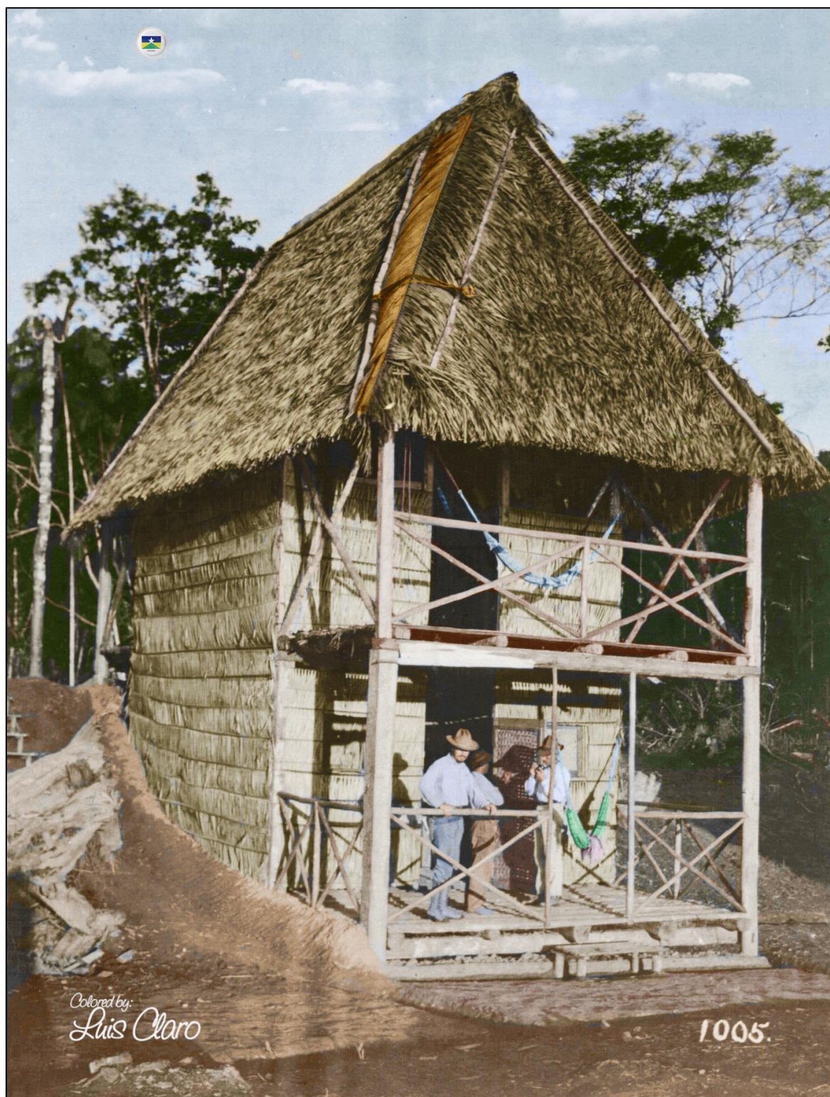
IMAGEM 15. Barraca de dois pavimentos, construída com madeira e palha (1911). Segundo Luis Claro, a barraca consistia na moradia do administrador do Acampamento 37, no quilômetro 259 da estrada de ferro. Foto nº 1005 de Dana Merrill. Fonte: Acervo de fotos da Estrada de Ferro Madeira-Mamoré colorizadas por Luis Claro
