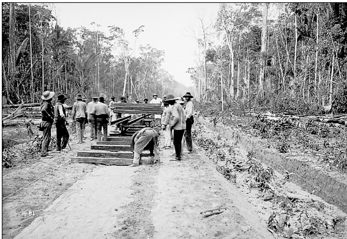
IMAGEM 4. Assentamento de dormentes e trilhos por operários. (1909-1910). Foto nº 481 de Dana Merrill. Fonte: Acervo do Museu Paulista da USP
