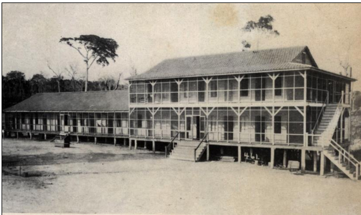
IMAGEM 21. Vista externa da Mad House , Casa 02. (1910-1911). Foto nº 461 de Dana Merrill. Fonte: Kravigny (1940)
