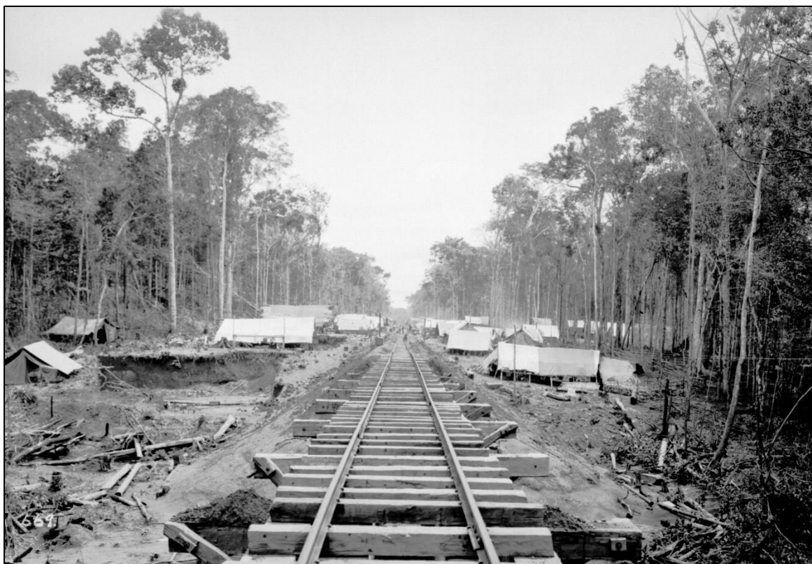
IMAGEM 19. Acampamento 15 ao longo dos trilhos da ferrovia. (1910-1911). Foto nº669 de Dana Merrill. Fonte: Acervo do Museu Paulista da USP
